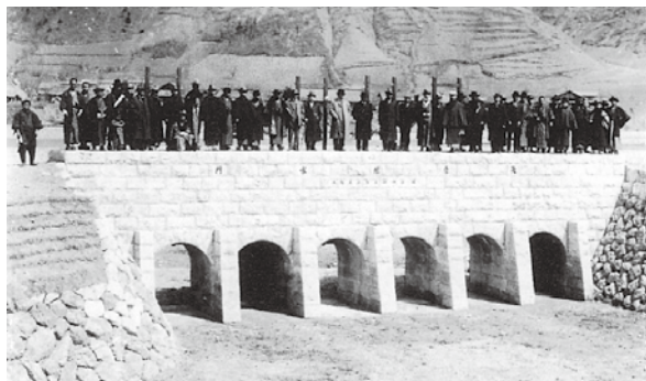
竣工当時の矢原堰水門
