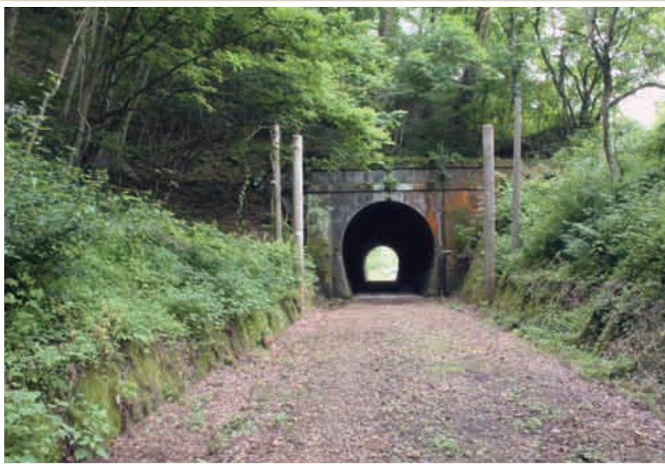
レンガ造の漆久保トンネル
