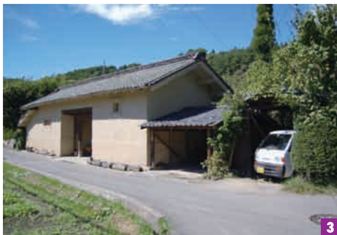
堀内宅の長屋門
