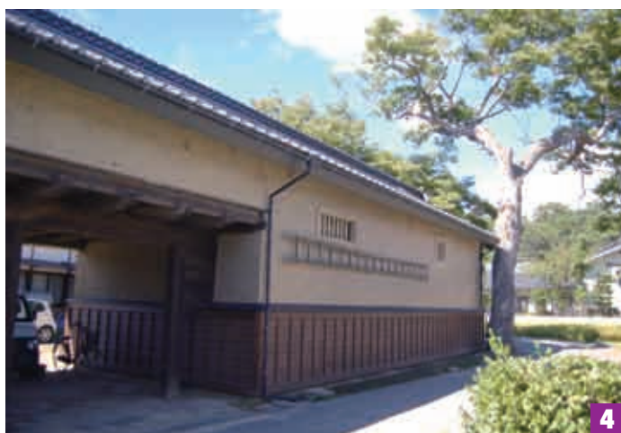
真島宅を西から見る
